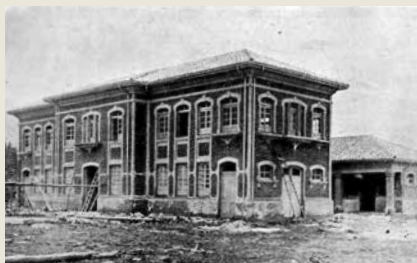
Pabellón de Lavandería, mecánica y ropería del Hospital San Juan de Dios en Bogotá. 1926. Duque Uribe, F. Declaraciones que fueron solicitadas por el señor Francisco Duque Uribe para acreditar la construcción de los edificios del Hospital de San Juan de Dios, que fueron levantados en el predio denominado Molino de la Hortua. Juzgado 4 del Circuito de Bogotá. 24 de Junio de 1927. Folio 7r número 6.
